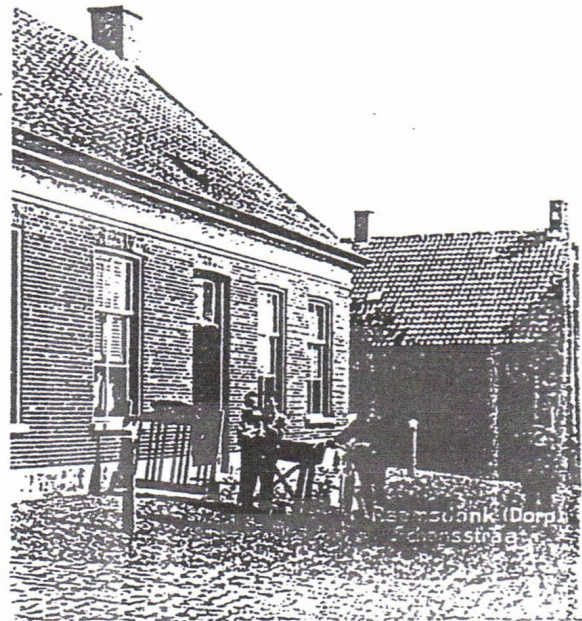
Hier is de brand uitgebroken.
