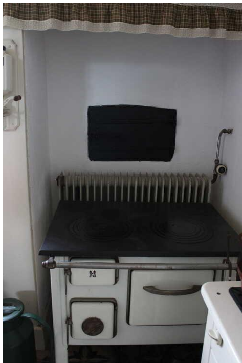
Figuur 8. Uitpandige oveningang in de muur van Heemkundig Museum Paulus van Daesdonck, Ulvenhout. De oveningang bevindt zich in een nis. Het oorspronkelijke ovengebouwje aan de buitenkant is afgebroken.
