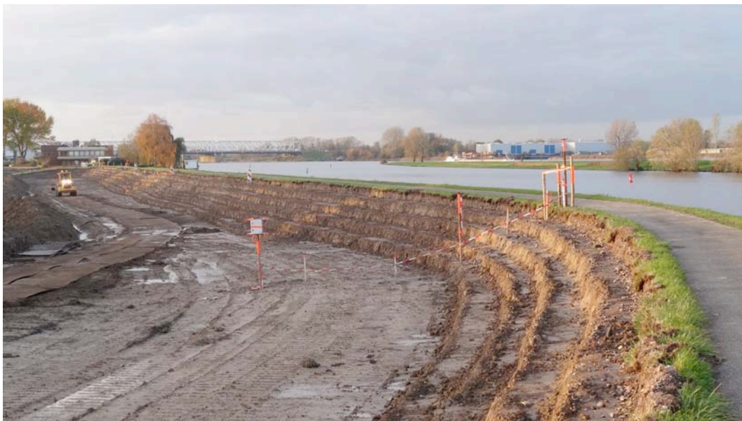
Figuur 16: Dijkversterking Amer-Donge in uitvoering (november 2013)
