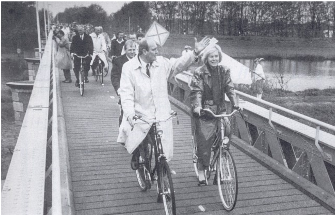
In 1992 werd het fietspad op de gerestaureerde Waalwijkse spoorbrug feestelijk geopend door Minister Maij-Weggen. Uiteraard op de fiets.
