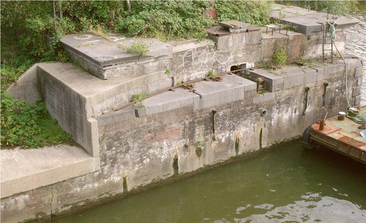
Oostelijke landhoofd, gezien naar het zuidoosten
