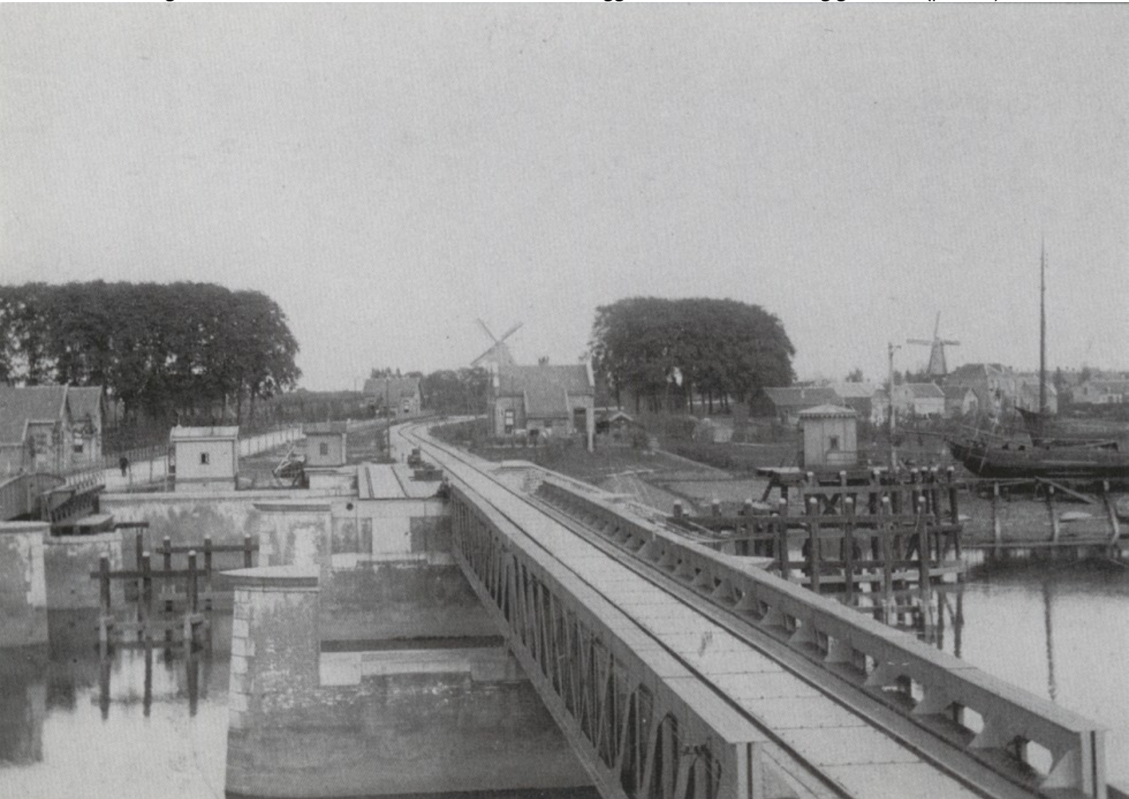
Foto uit 1893, genomen vanaf het westelijk landhoofd naar het oosten. Rechts eerst de twee vaste overspanningen van de spoorbrug. Daarachter de dubbelsporige draaibrug. Links de verkeersbrug, waarvan we nog juist de rolbrug en de laatste aanbrug zien (foto Regionaal Archief West Brabant)
