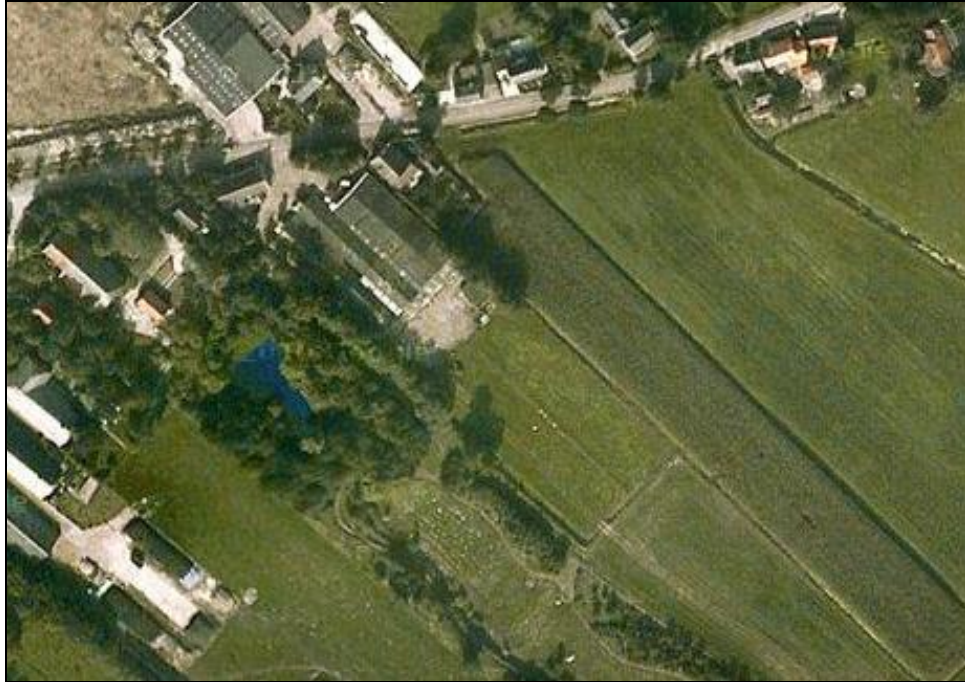
Figuur 11 : luchtfoto bestaande situatie plangebied (bron: Google Maps)
